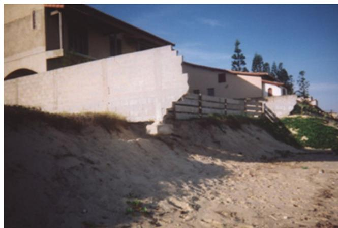
Figura 13 - Praia de Ponta Negra após a ressaca de maio de 2001 mostrando a destruição total da Avenida Litorânea e do muro de uma casa. (Foto: Flavia Lins de Barros).
