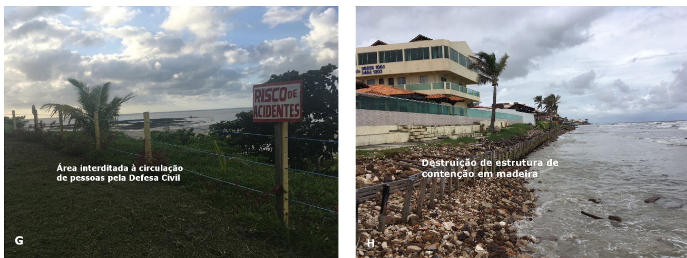
Figura 11: Medidas de contenção da erosão em Salinópolis: (G) parte central do Setor de Falésia Leste interditado; (H) estrutura de contenção da erosão em madeira e rochas destruídas na praia do Atalaia.
